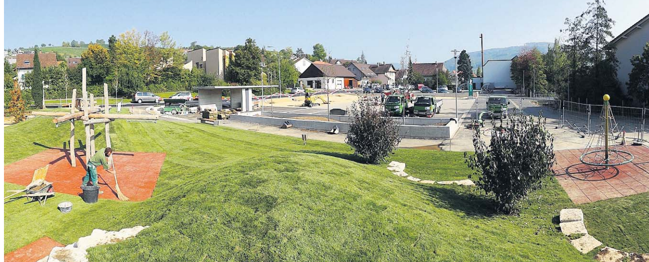
Der Pausenplatz bei der Schule geht nahtlos in das neue Magdener Dorfzentrum über.
